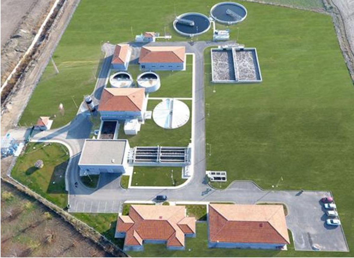
Şekil 4.27. Merzifon Atıksu Ön Arıtma Tesisinden Görünüm (Gezer Sanayi A.Ş. Fotoğrafı)
